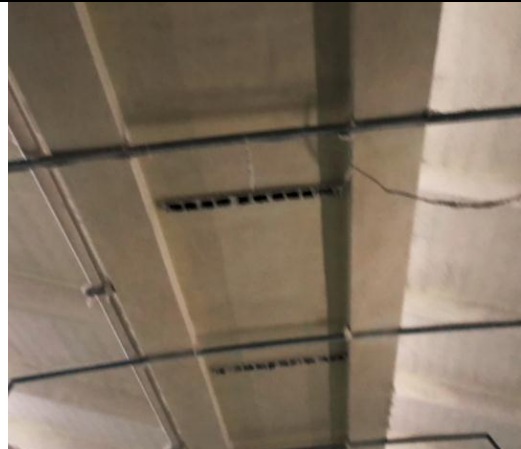
织布车间内上部送风口
