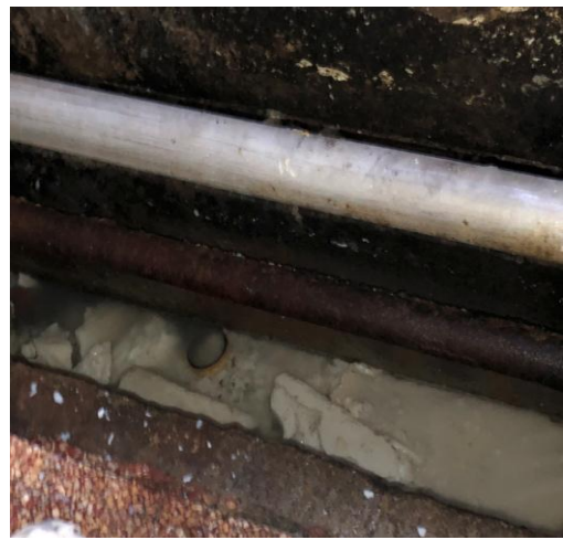
车间浆纱废水收集沟
